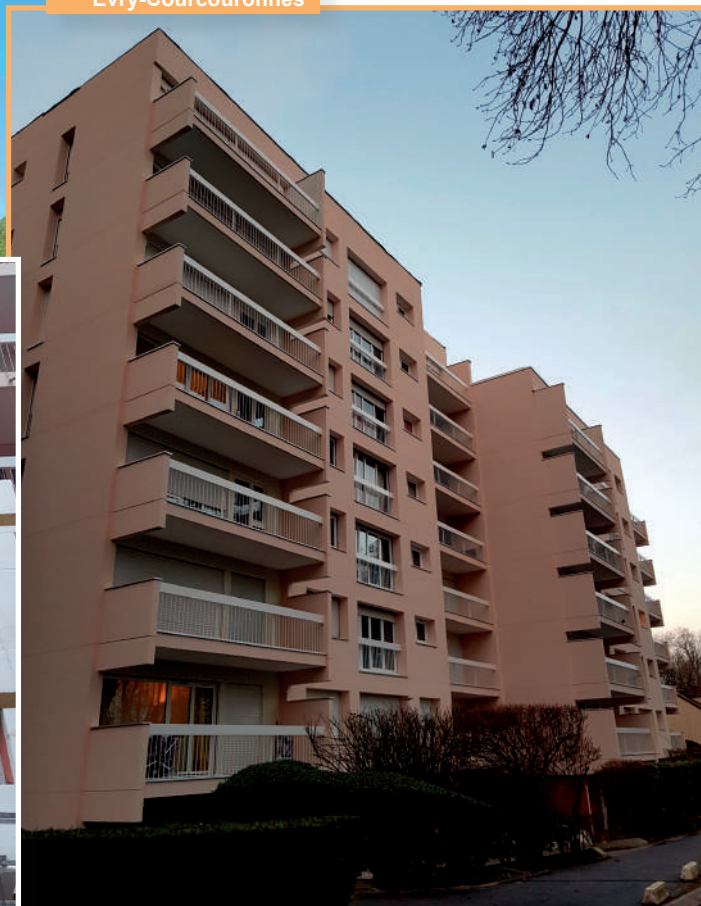
Travaux avant/après Rue du parc aux biches Évry-Courcouronnes
